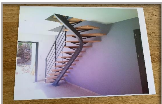
Figure 7 – Escalier métallique et marches bois
