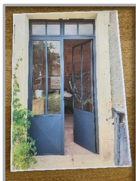
Figure 11 – Porte métallique vitrée
